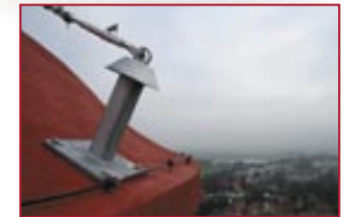
Contrôle des installations sur des sites d'accès difficile
