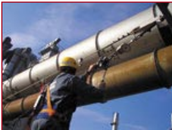
Test d'effort sur ancrage de ligne de vie
