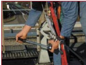
Contrôle de serrage (vérification périodique dans un environnement à fortes vibrations)
